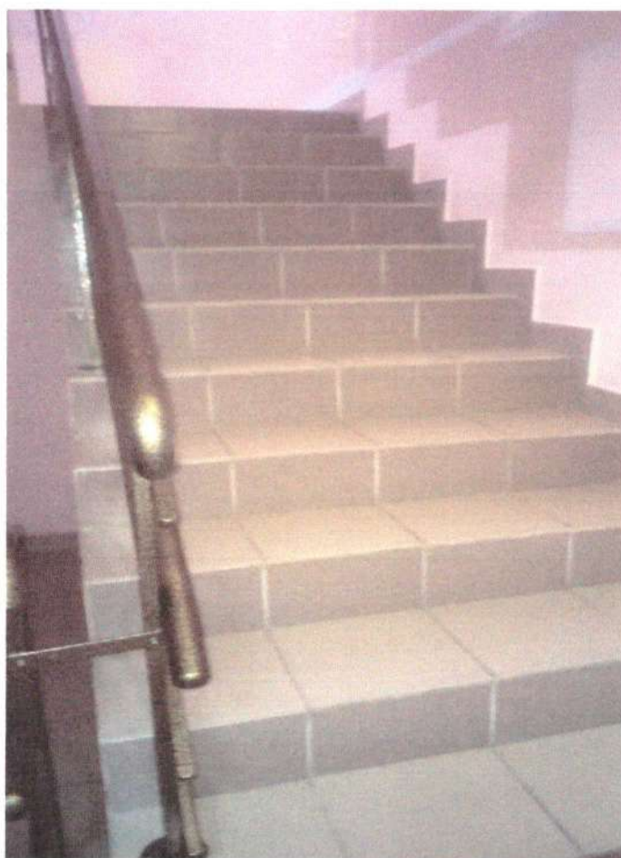
Фото № 11 Лестница (внутри здания)
