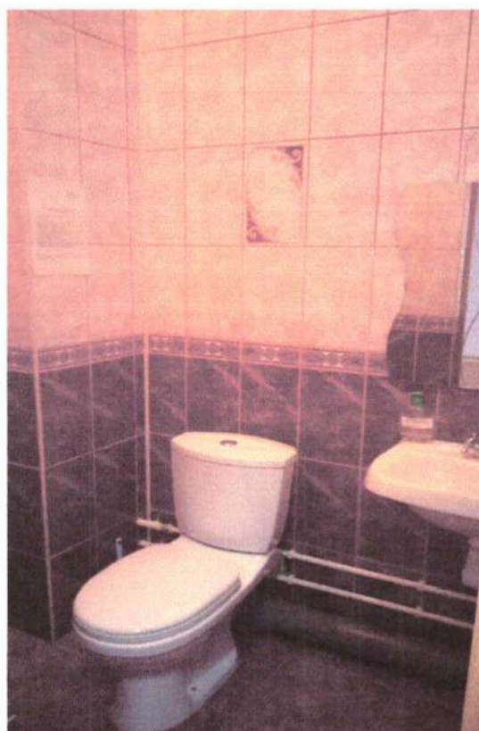
Фото № 24 Санитарно-гигиеническое помещение
