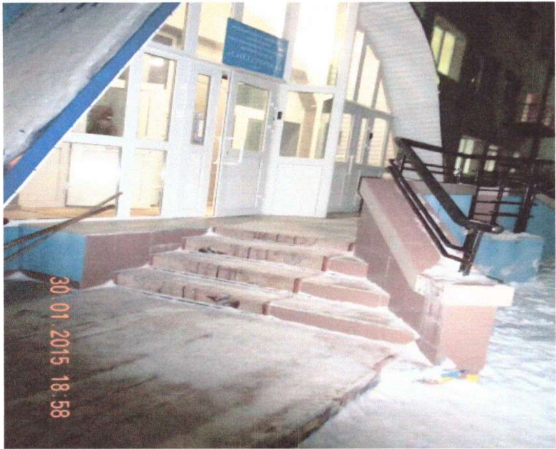
Фото № 6 Лестница наружная (центральный вход)
