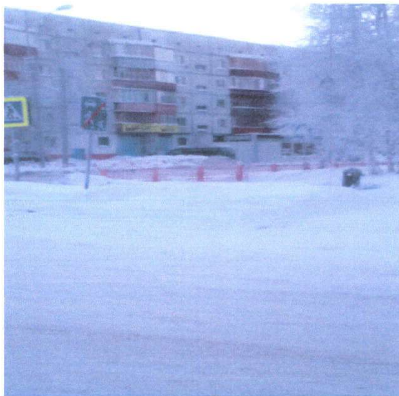
Фото № 27 Путь (пути) движения со двора дома №6а по ул.50 лет ВЛКСМ к пешеходному переходу через ул. 50 лет ВЛКСМ
