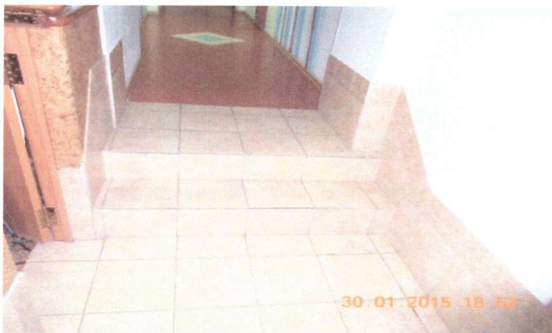
Фото № 12 Лестница в вестибюле
