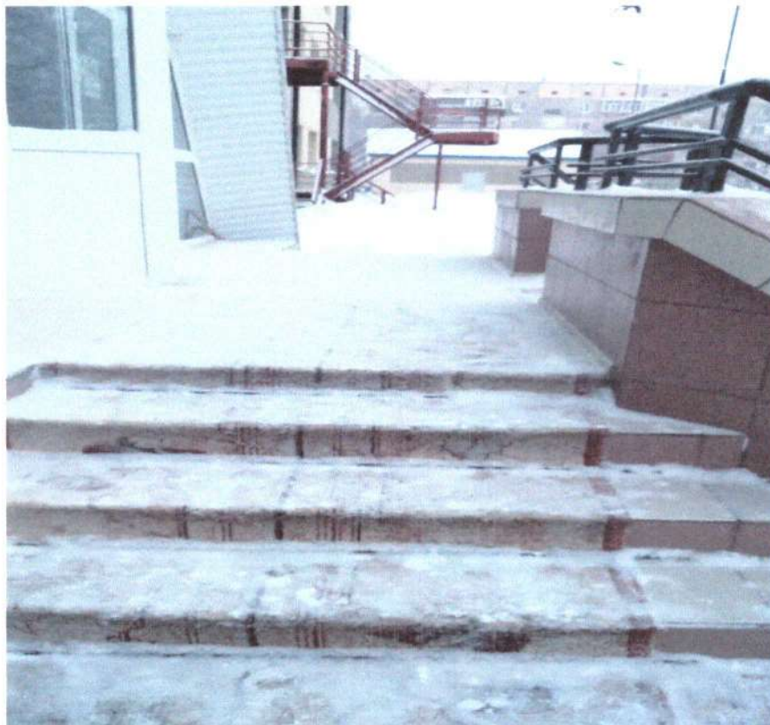
Фото № 6а Входная площадка (перед дверью)
